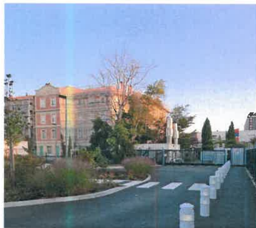
Accès piéton rue Frédéric Sévène
