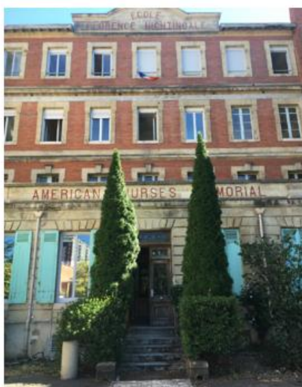
Accès piéton rue Robespierre
